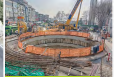
İstanbul Beşiktaş Metro İnşaatı
